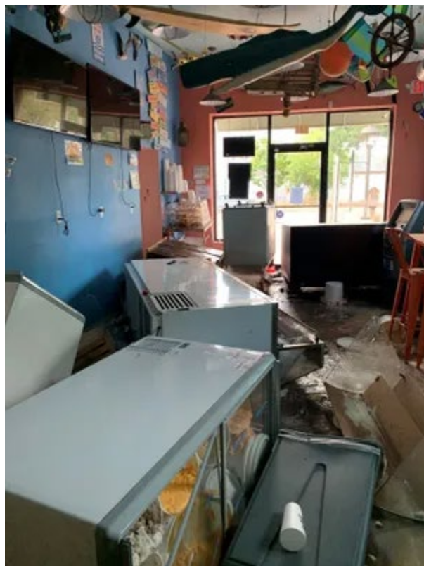
Fig. 9: Estragos de la inundación en la heladería Summer Ville Ice Cream Shop en Somerville, Nueva Jersey.
