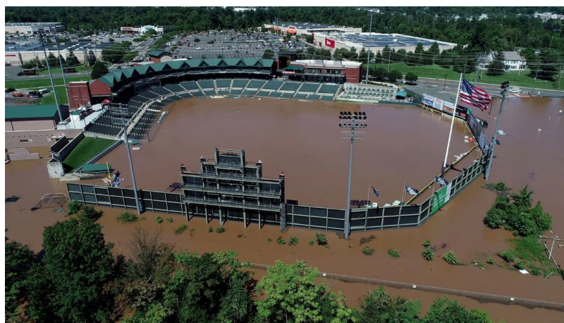
Fig. 8: Estadio de béisbol del TD Bank inundado por precipitaciones del huracán Ida.
