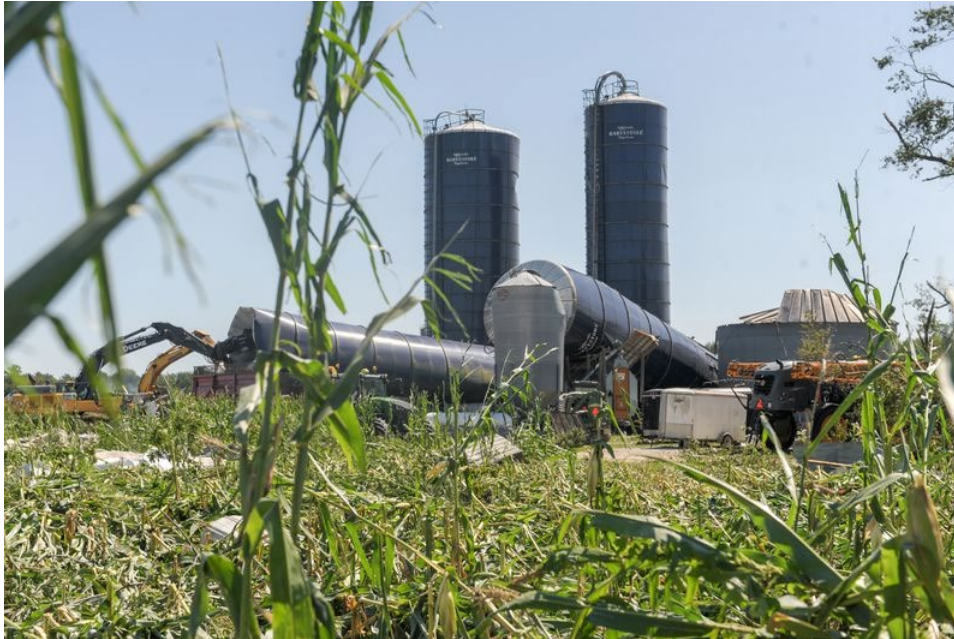
Fig. 10: Daños por tornado en Wellcrest Farms en Mullica Hill, Nueva Jersey, jueves 2 de septiembre de 2021.
